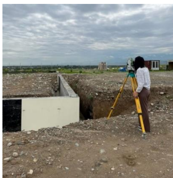
21 Сурет – TS 09 plus тахеометрімен түсіріс жасау
